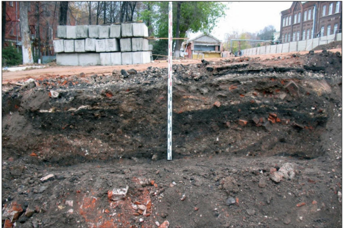
Илл. 24. Н. Новгород. Зона демонтажа здания на Нижне-Волжской набережной, 1/1. Котлован. Зачистка №1. Вид с запада-юго-запада.
