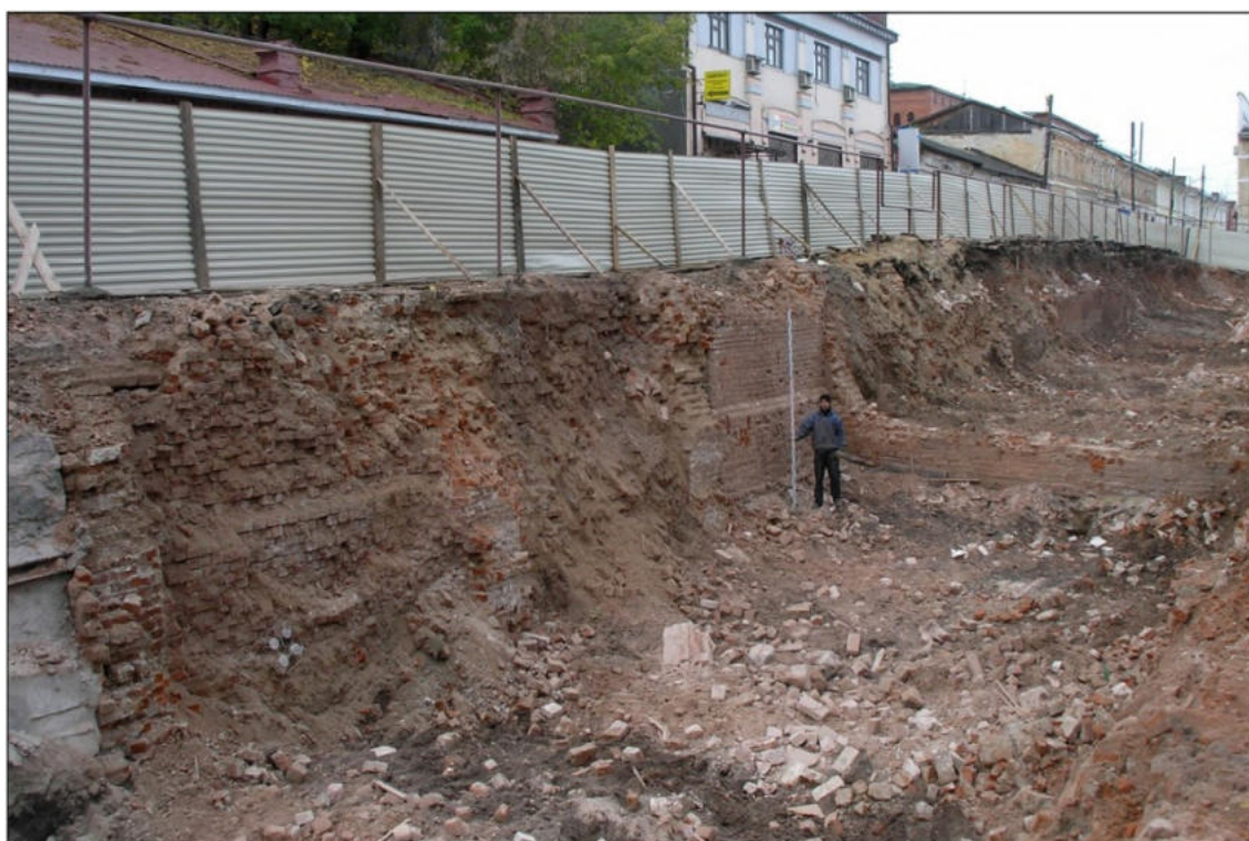
Илл. 23. Н. Новгород. Зона демонтажа здания на Нижне-Волжской набережной, 1/1. Котлован. Восточная часть южного борта. Вид с северо-востока.
